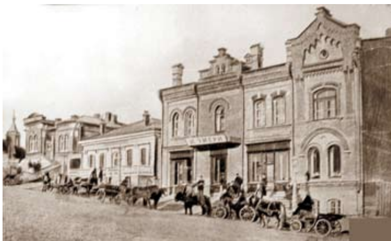
Дом Эмери по улице Алексеевской. В 1914 году в это здание было переведено с улицы Лисуновской Унтербергеровское училище. Сейчас в надстроенном четырехэтажном здании находится школа № 35
